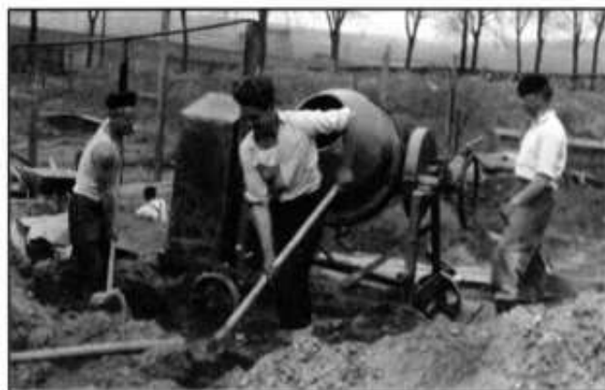
Betonowanie fundamentów nowej szkoły
