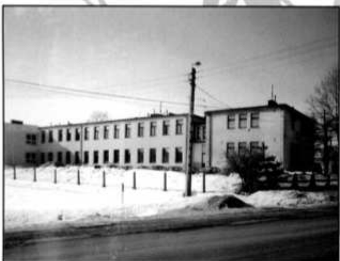
Budynek Zespołu Szkół Nr 5
