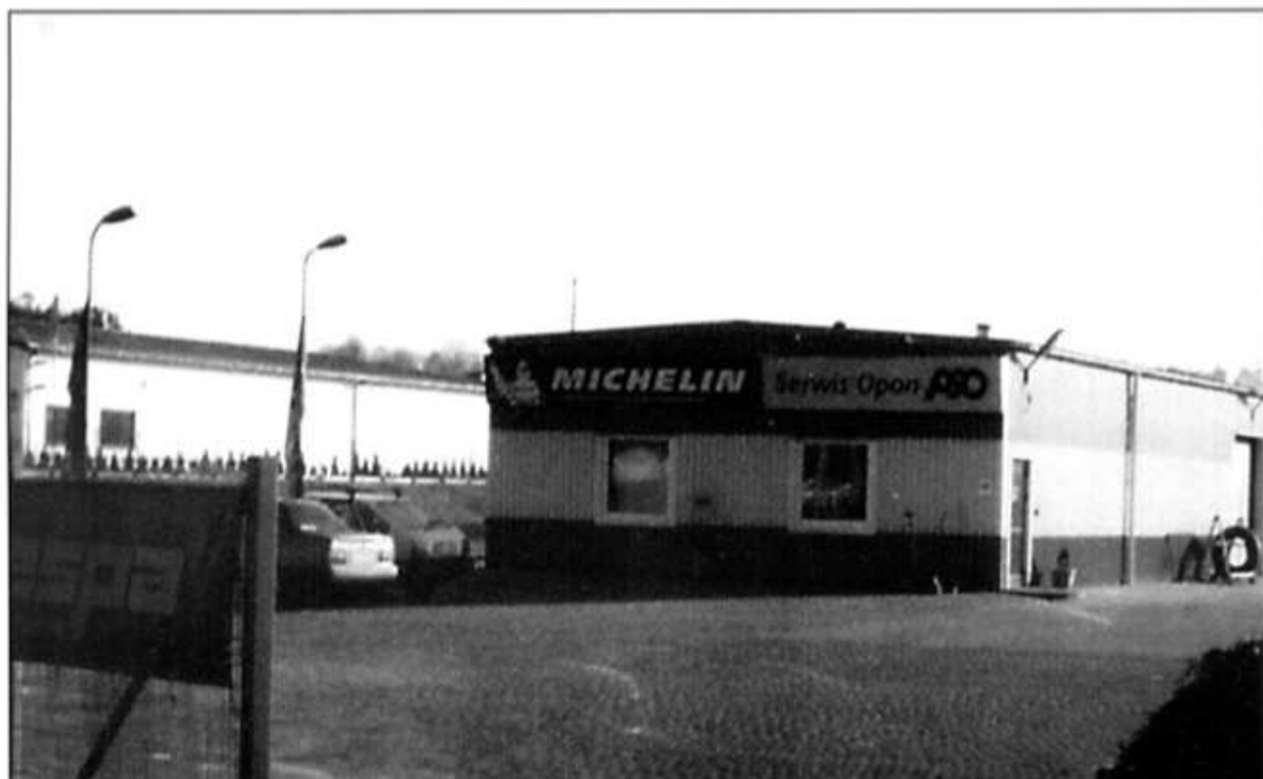
PPHU Krus – Bruk działa od 15.11.2004 r. – wymiana oleju, serwis ogumienia samochodów osobowych, maszyn budowlanych, myjnia ręczna, mini market, części samochodowe
